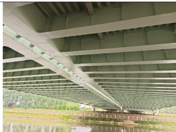
淠河总干渠大桥底部钢构
