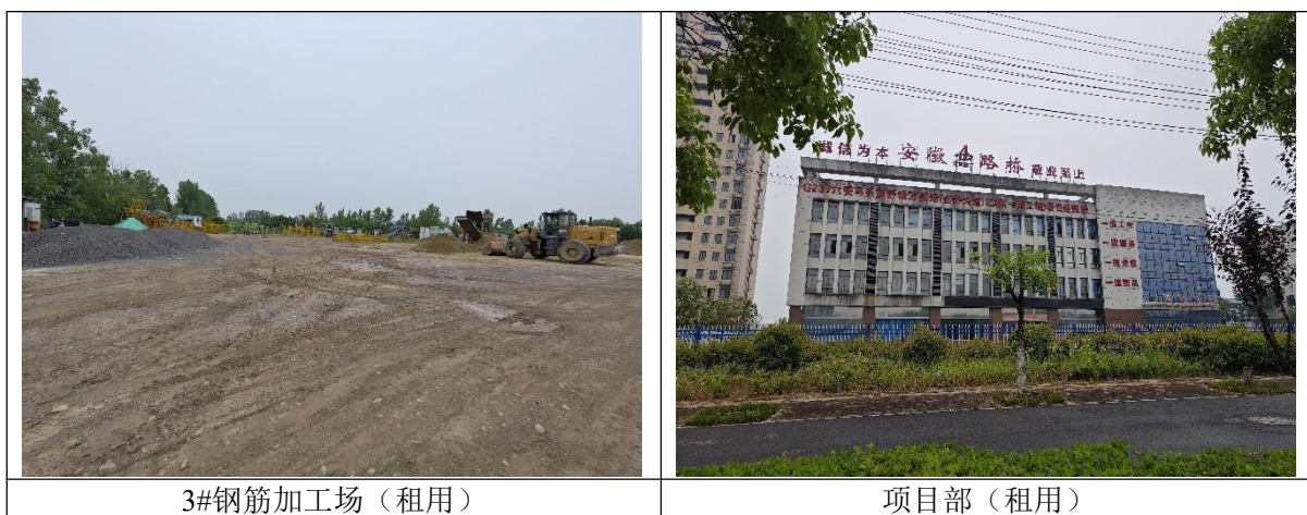
图2.4-3 施工场（营）地现状图
