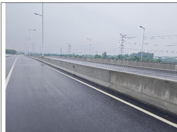
淠河总干渠大桥防撞墩
