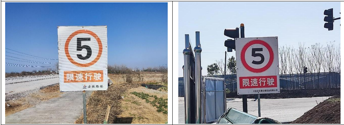
施工便道限速标示
