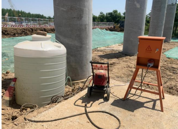
车辆冲洗设施
