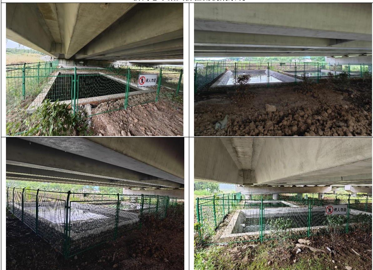
淠河总干渠大桥事故收集池
