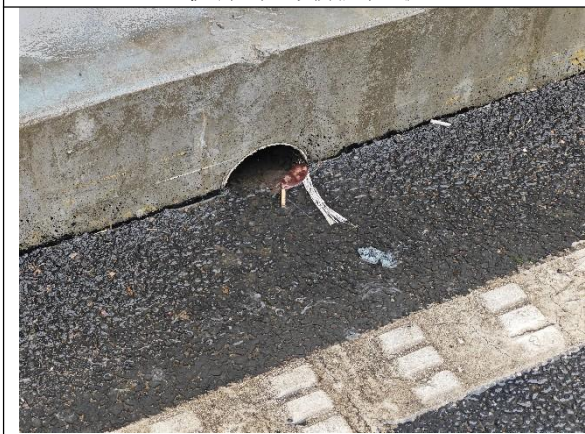
淠河总干渠大桥泄水孔
