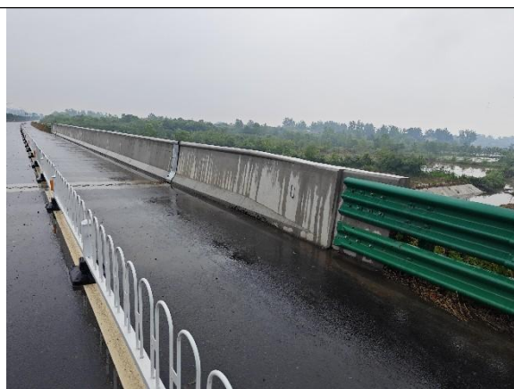
姚大庄中桥防撞墩
