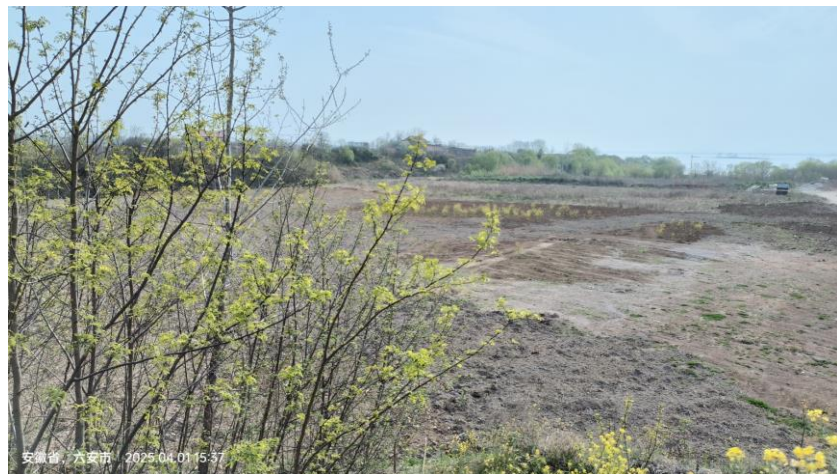
03 标水稳拌合站
