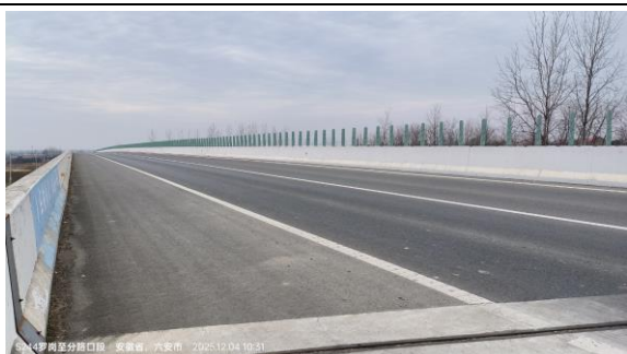
K14+945 汲东干渠大桥两侧防撞护栏
