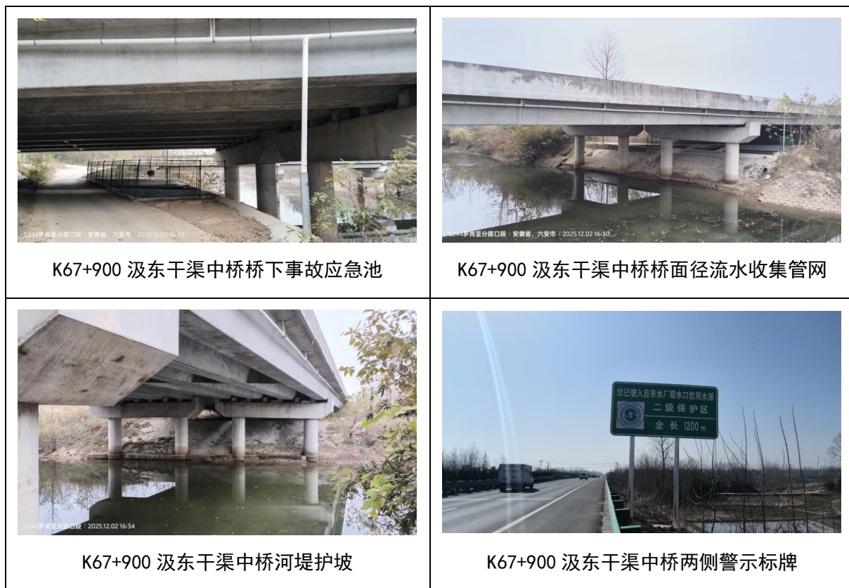
图 8.3-1 敏感路段水污染防治设施照片
