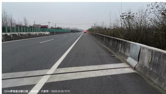
K67+900 汲东干渠中桥两侧防撞护栏
