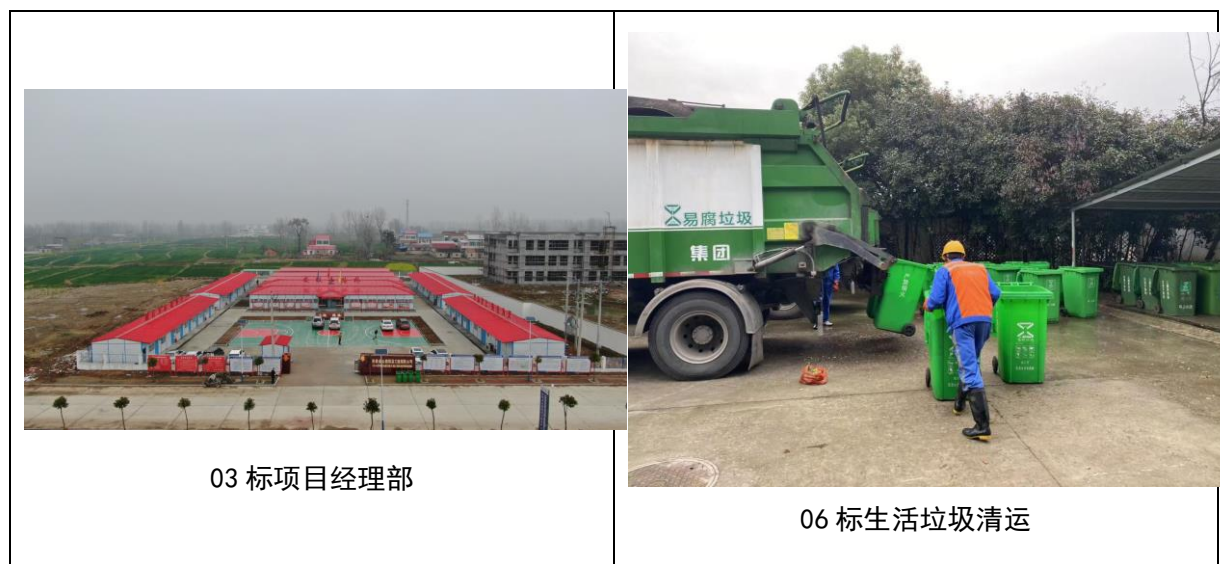
图 9.1-1 施工期临时场站环境卫生状况照片
